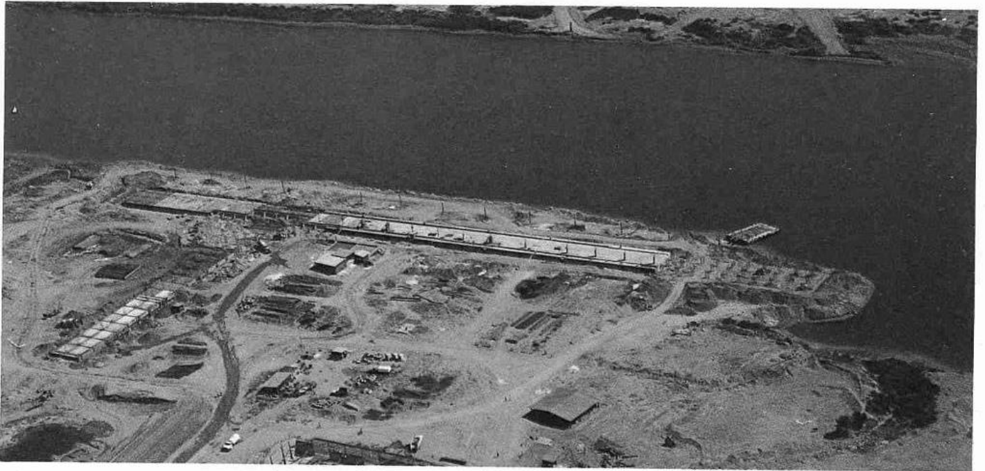
Vista general del muelle en "T" para la terminal granelera de Lázaro Cárdenas, Mich.; abajo un acercamiento a la zona de trabajo.
