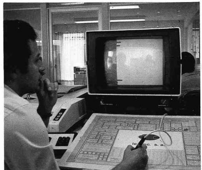
Arriba, tableta digitalizadora; abajo, estación de diseño interactivo con pantalla de color.
